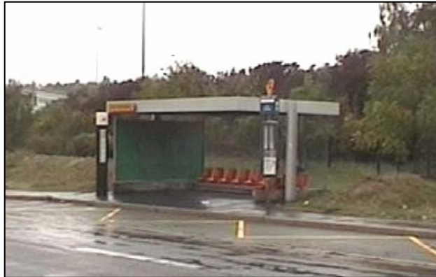
Figure 4 : Equipement d'un arrêt sur la ligne express Cergy - Roissy
