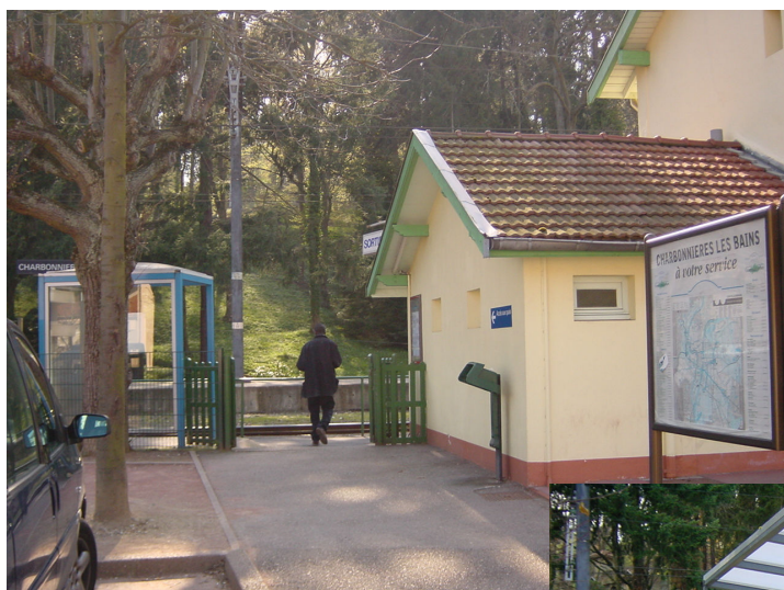
Figure n°6 : l'accès complémentaire de la gare avant les travaux.
