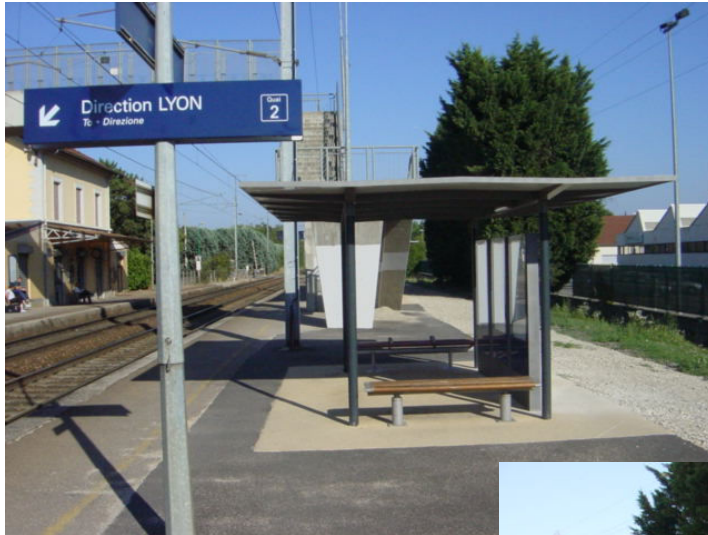
Figure n°11 : vue du quai direction Lyon.
