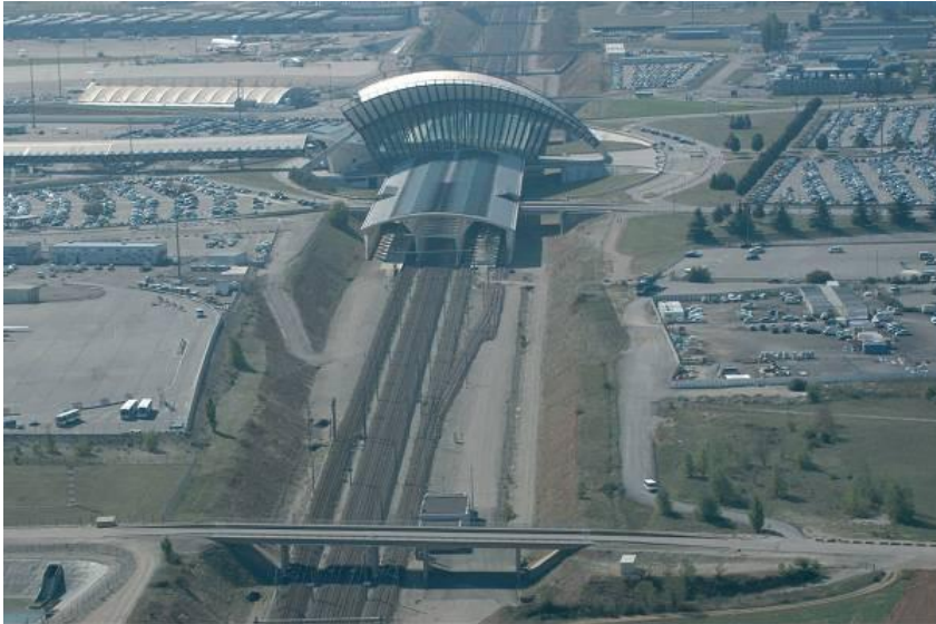
Photo 2 : Vue de l'aéroport St Exupéry avant les travaux Rhônexpress (source : CFTA Rhône)
