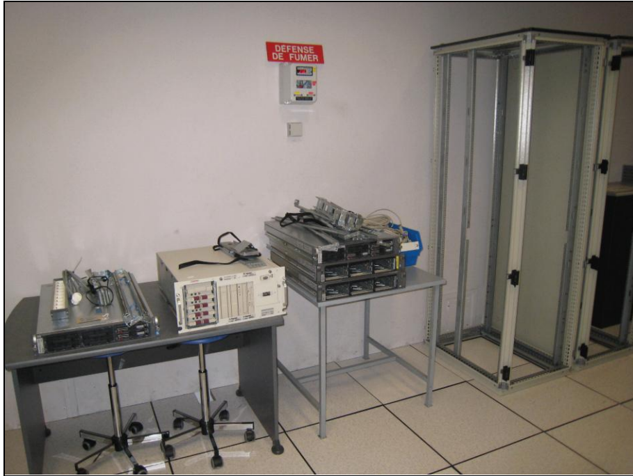
FIGURE 29 : SERVEURS ET ARMOIRES SUPPRIMES SUITE AU DEPLOIEMENT DE MALAUNAY
