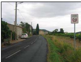
Entrée du village de Montaud - Zone 30
