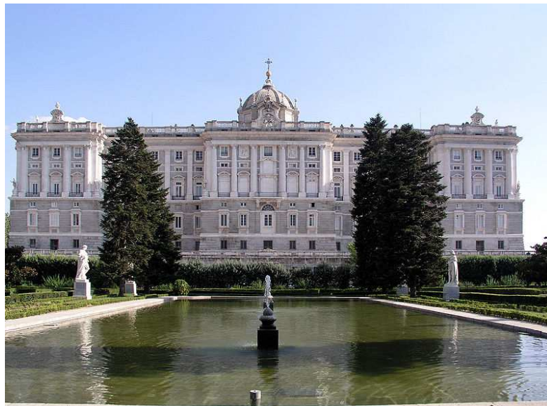
Palais Royal actuel (façade nord)
