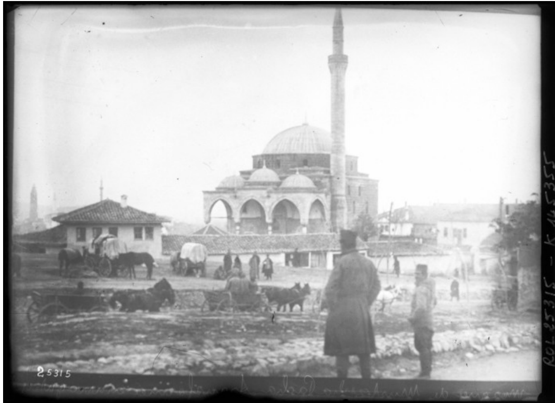
Mosquée de Mustapha Pacha transformée en dépôt de munitions
