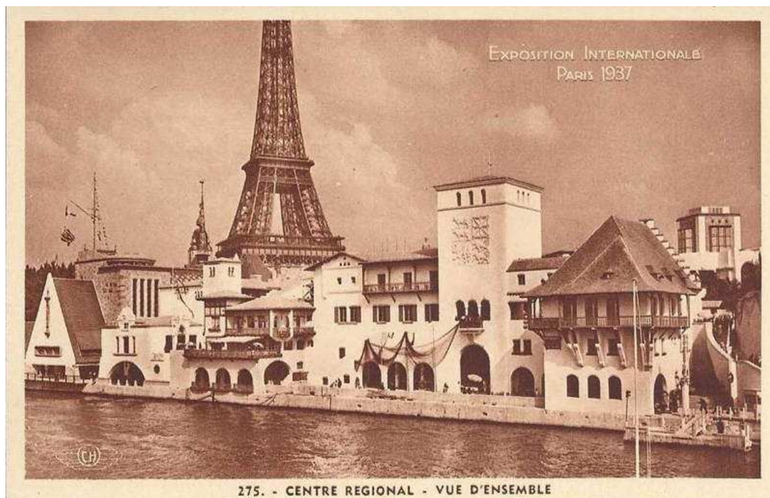
Figure 25 - Centre régional - vue d'ensemble, H Chipault
