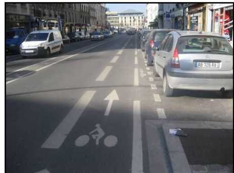
Figure 25 : Bande sur chaussée, Issy, source : Systra, 2010
