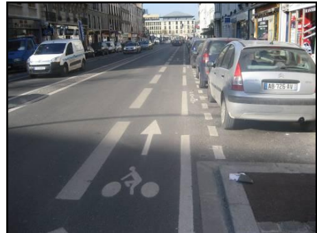
Figure 25 : Bande sur chaussée, Issy, source : Systra, 2010
