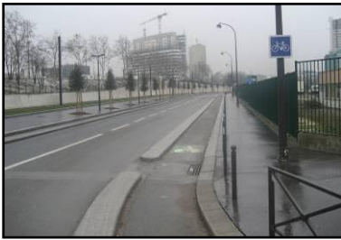
Figure 24 : piste sur chaussée, Issy, source : Systra, 2010
