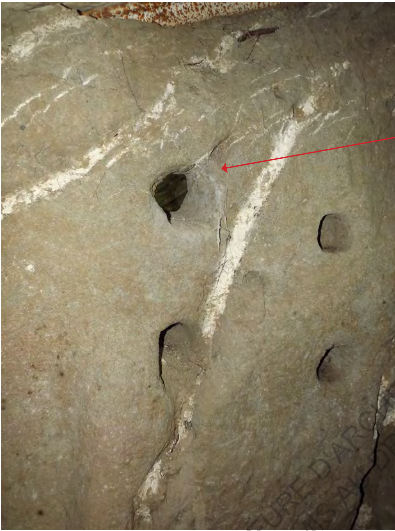
Figure 51 : Orifices percés dans la paroi de la zone 2
