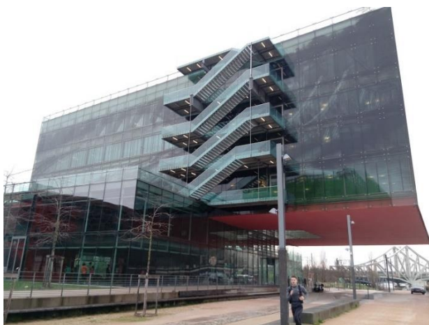
Figure XXXIII : Dark Point (façade nord), Antoine Barbin, 16 février 2018.
