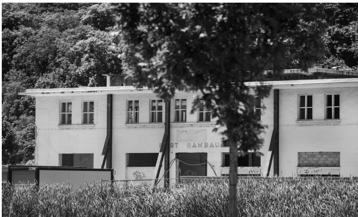
Figure XVI : L'ancien bureau de direction (Capitainerie) à l'abandon, Crédits photographiques Héloïse Peyre, Site du Groupe Cardinal, 2016.
