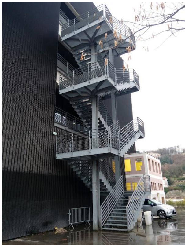
Figure XXXVIII : Escaliers métalliques sur le pignon nord des Douanes, Antoine Barbin, 16 février 2018.
