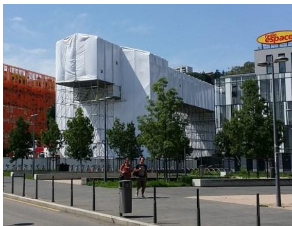
Figure XLIV : Opération de sablage durant la réhabilitation du pont-roulant nord, Crédits photographiques Garbougat (Copyright), 7 août 2014.
