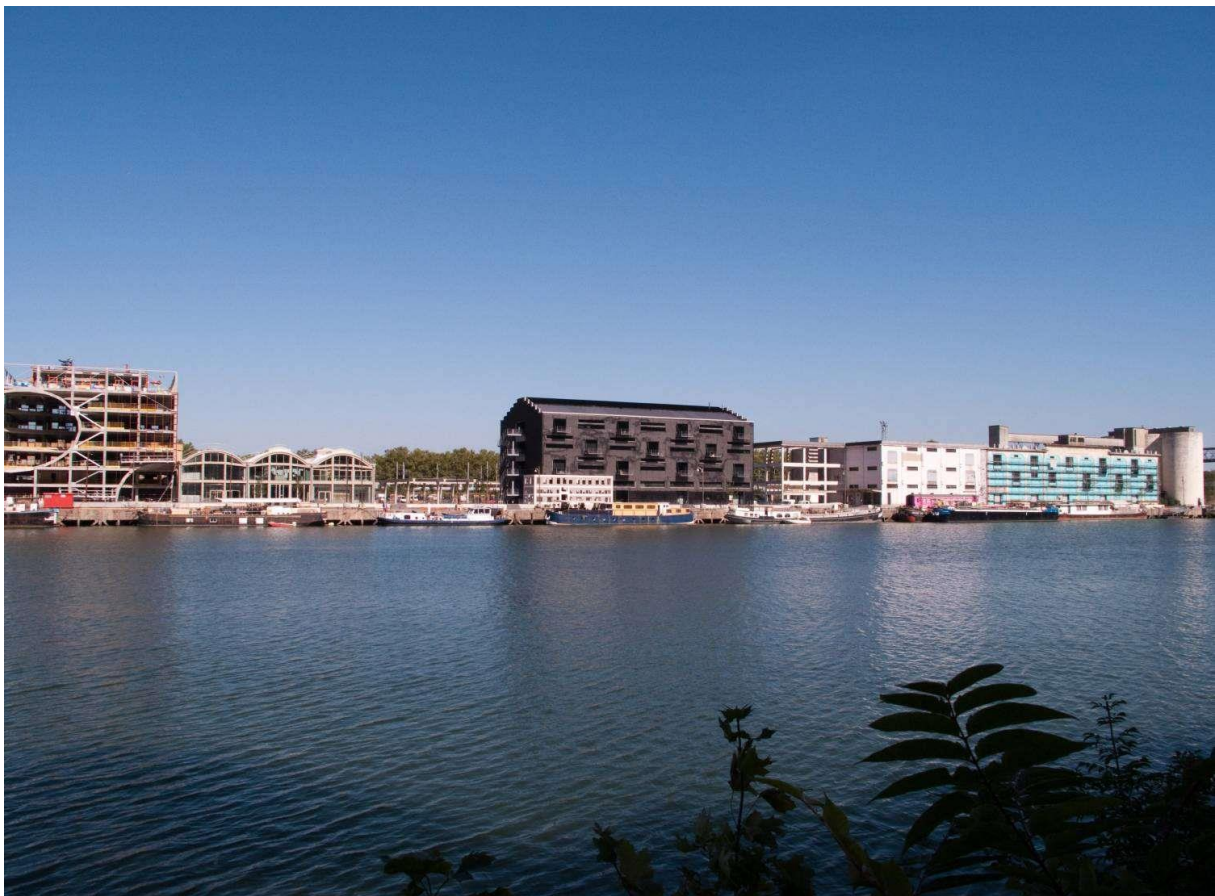
Figure XXXIV : Vue d'ensemble des travaux de la Confluence, Nicolas Daum, BML (P0732 002 00035), 4 août 2009.
