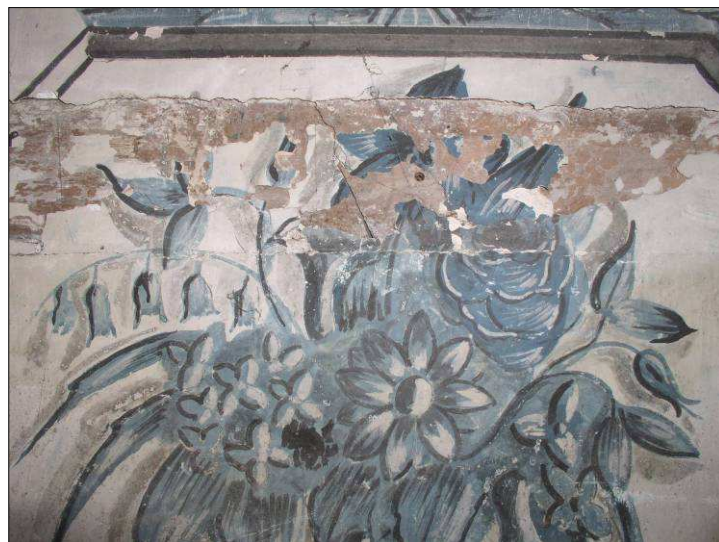
Peintures murales, La Doménie, avant restauration.
