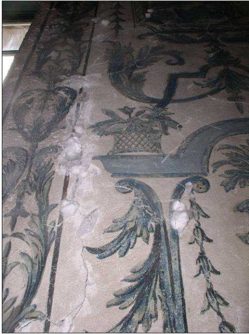
Consolidation de l'enduit et comblement des fissures, pendant la restauration.
