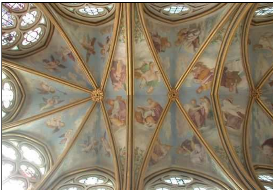
Chalis, Vue d'ensemble de la voûte de la nef.
