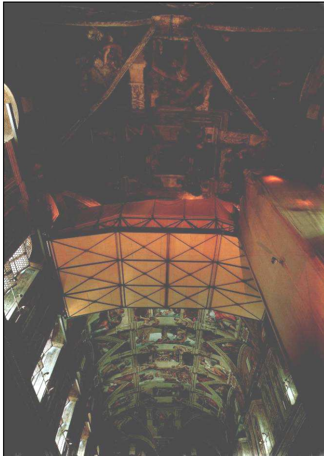
Vue de la voûte de la chapelle Sixtine montrant la plateforme mobile Sur laquelle travaillaient les restaurateurs, avec son ascenseur sur la droite. La partie nettoyée du plafond est clairement visible en bas de l'image.
