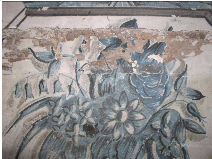
Peintures murales, La Doménie, avant restauration.
