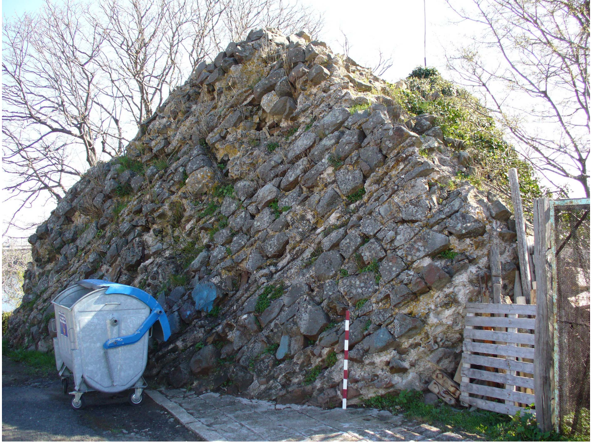
PLANCHE 21. Vestige du rempart de l'agglomération antique d' Aulaiouteichos (auj. Ahtopol) détruit par un violent séisme à l'époque hellénistique.
