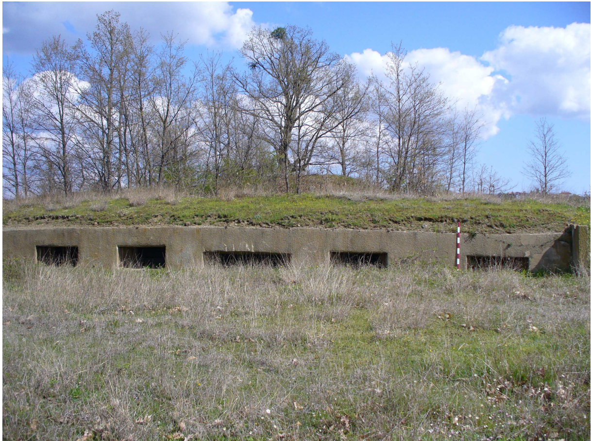
PLANCHE 24. Avec l'approche de la zone frontalière, la présence d'ouvrages militaires bétonnés du XX siècle n'échappe pas au regard: ici, à l'est de Bulgari, un bunker construit à quelques mètres d'un grand tumulus de terre (au centre, au second plan).
