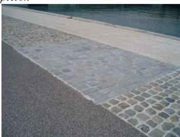
Figure 12 : Pavés arasés pour permettre le passage vers le ruban piéton
