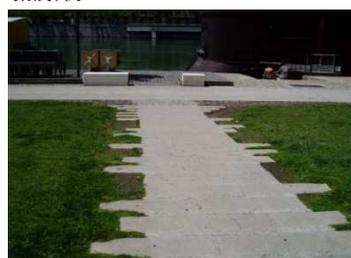
Figure 14: Chemin de traverse aux joints bétonnés
