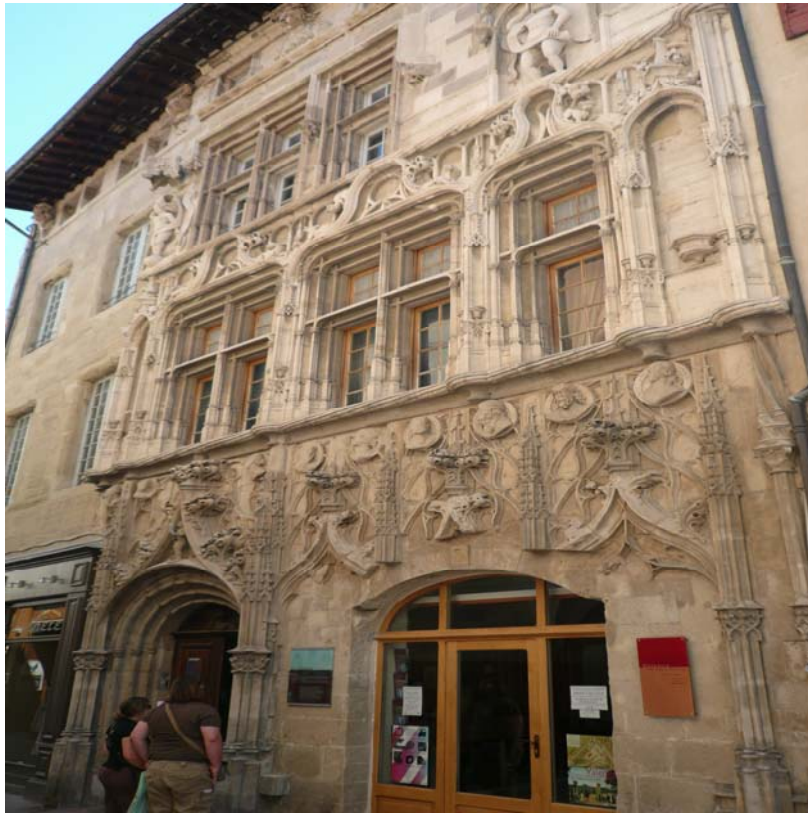
Cliché Nicolas Danjaume (la façade donnant sur la Grand'rue)
