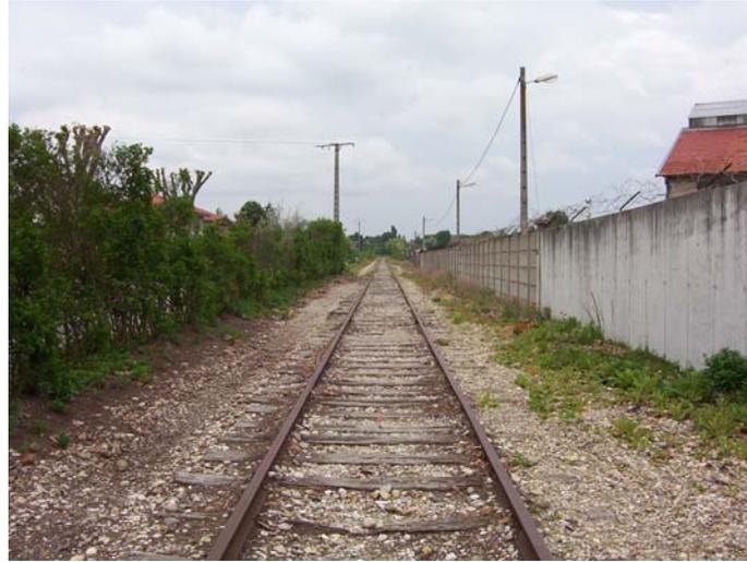
La plate-forme à proprement parler est constituée d'une grave alluvionnaire et non d'un ballast ferroviaire classique (cf. figure 22). Son état de nivellement démontre une bonne qualité de la plate-forme. Le point noir est le développement de la végétation dans certaines zones détaillées précédemment. D'autre part la plate-forme peut être ponctuellement dégradée par des empiètements de voiries ou autres.
