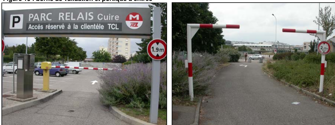
Figure 19 : borne de validation et portique d'entrée
