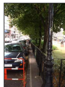
Trottoir trop étroit
