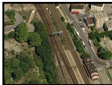
Figure 6 : La gare de Saint-Fons et le souterrain cycliste.
