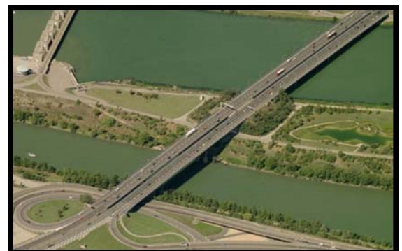
Figure 3 : Pont de l'A7 sur le Rhône
