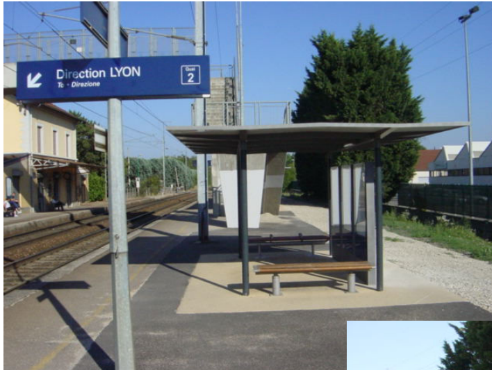
Figure n°11 : vue du quai direction Lyon.
