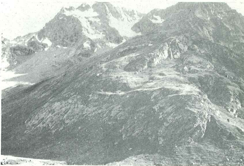
Photo 15 - Vue vers le sud-ouest du Trias de la Bosse de Chamoissière : il forme un petit rebord abrupt à droite de la partie supérieure de la photo.
