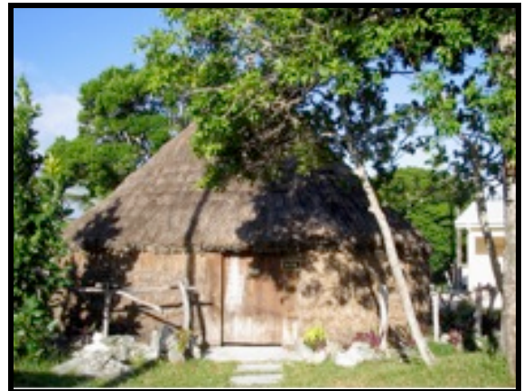
Figure 13. La case du Lycée d'Enseignement Professionnel (Lekine). (Cliché pris par l'auteur, 2007).
