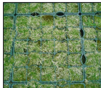
Les dalles végétales utilisées comme revêtement des parkings, Route de Vannes, Nantes, France
