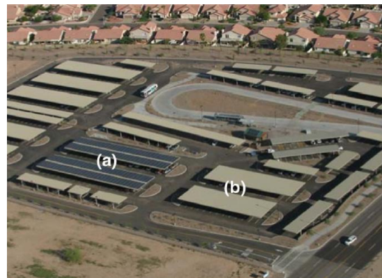
Photo aérienne du site des parkings utilisé dans la recherche Phoenix, Arizona, U.S.A. (Golden et Coll. 2007)
