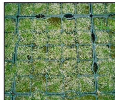
Les dalles végétales utilisées comme revêtement des parkings, Route de Vannes, Nantes, France
