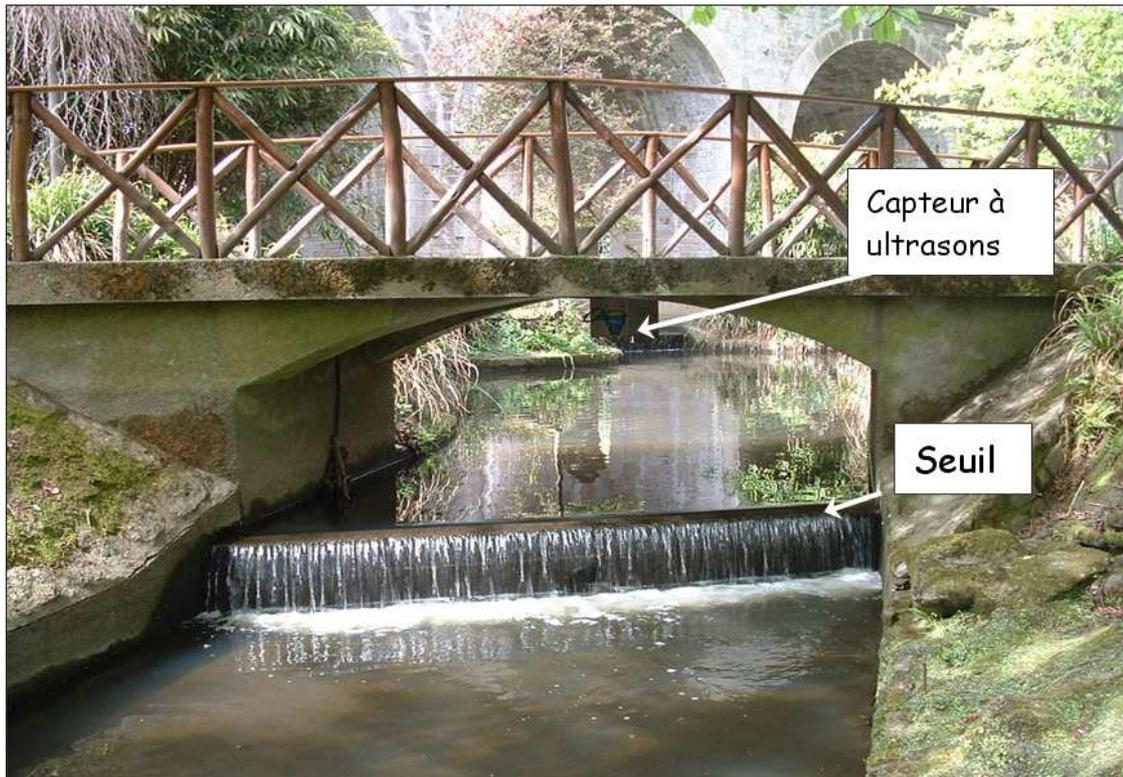
**Figure 12. Station limnimétrique: localisation du seuil et du capteur qui mesure les hauteurs d'eau**
