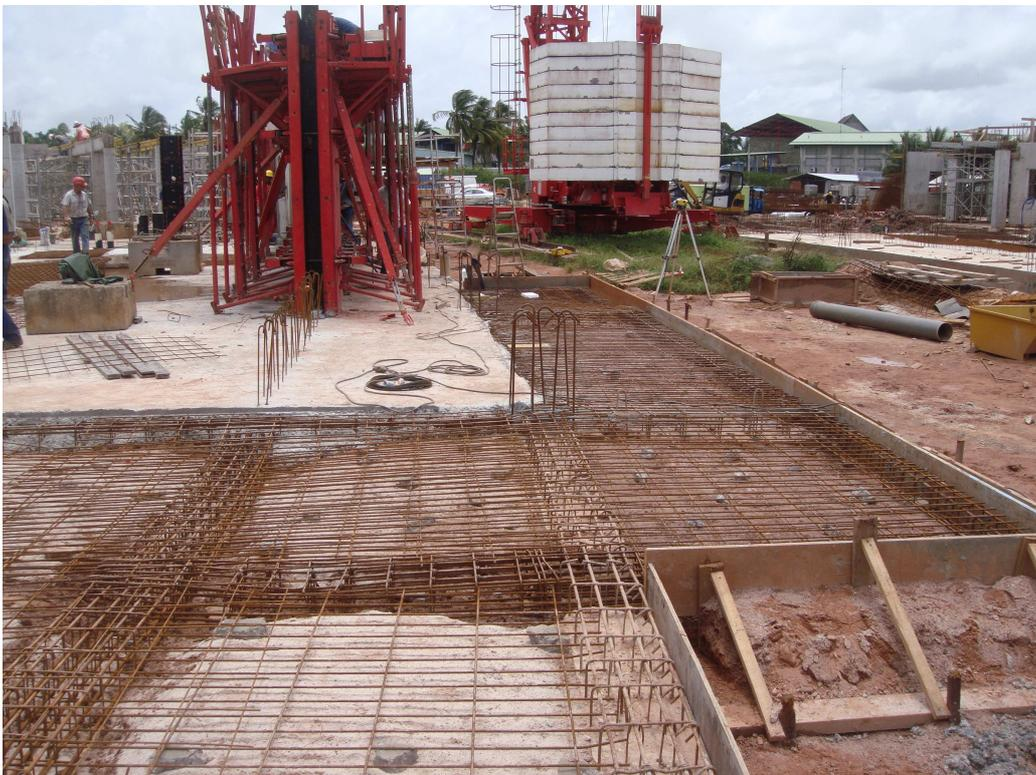
*Photo 6 : ferrailage du dallage avant coulage du béton*
