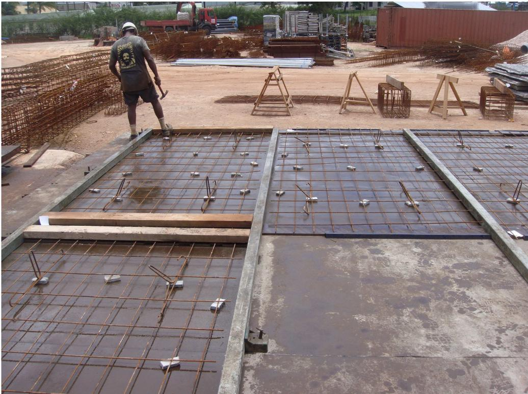
*Photo 8 : préfabrication des prédalles*
