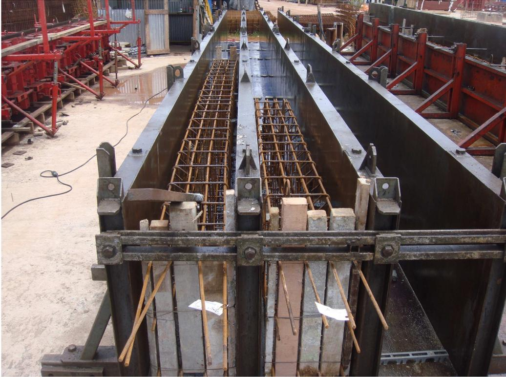
*Photo 7 : préfabrication des poutres droites*
