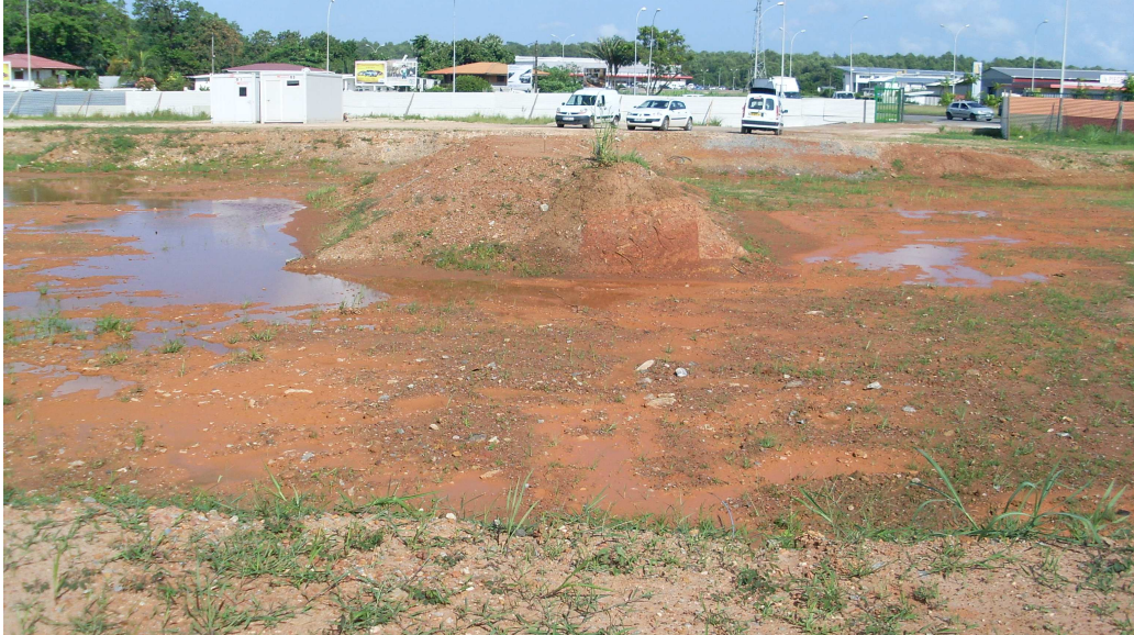
Photo 1 : réception du fond de fouille
