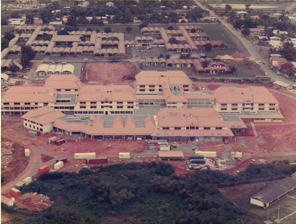
Photo 19 :construction de l'hôpital de Cayenne en 1991 par Nofrayane
