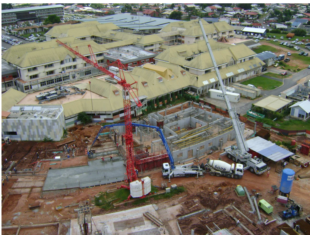
Photo 16 : zone B1 vue de la grue Mars 2010
