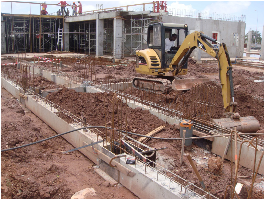
Photo 5 : remblaiement entre les longrines
