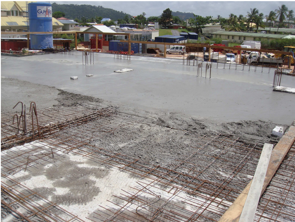
Photo 12 : coulage de la dalle de compression du plancher
