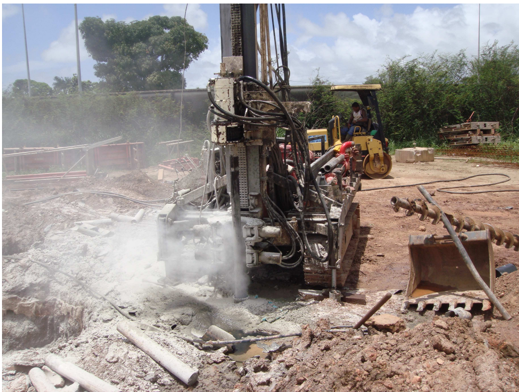
Photo 2 : forage dans le rocher
