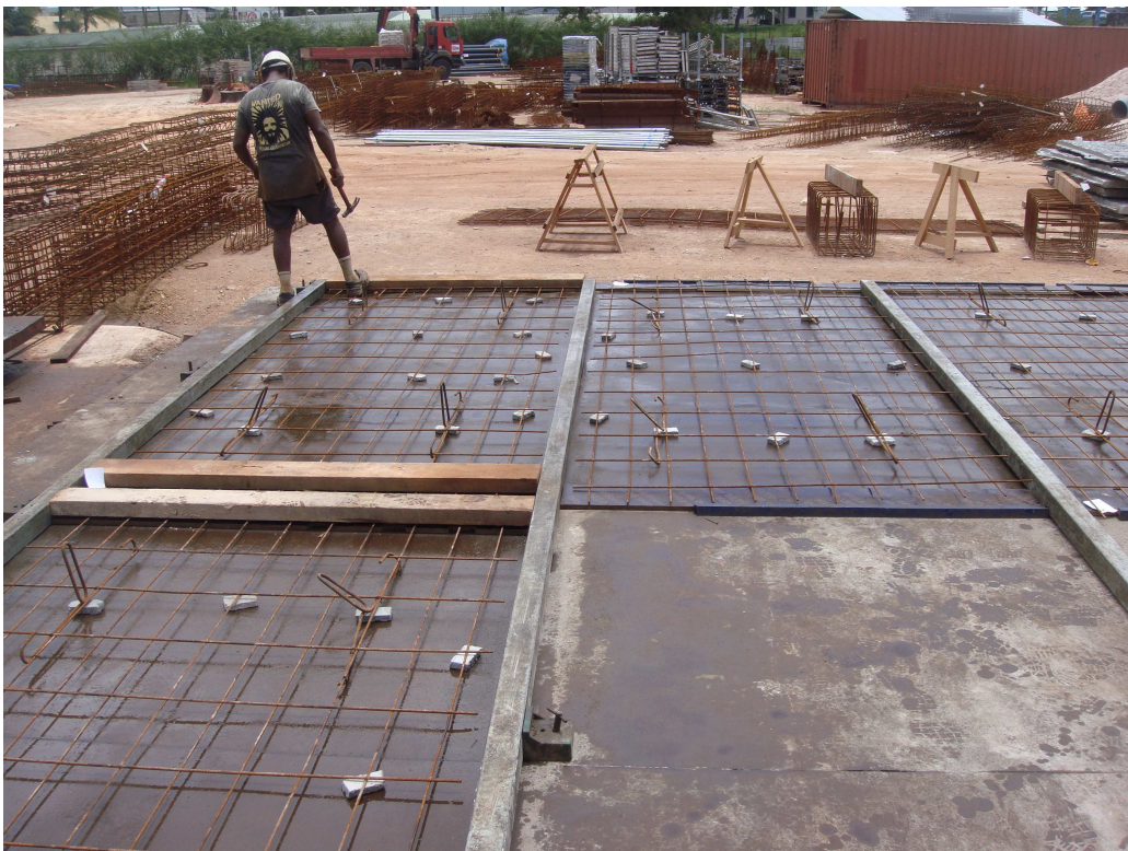
Photo 8 : préfabrication des prédalles
