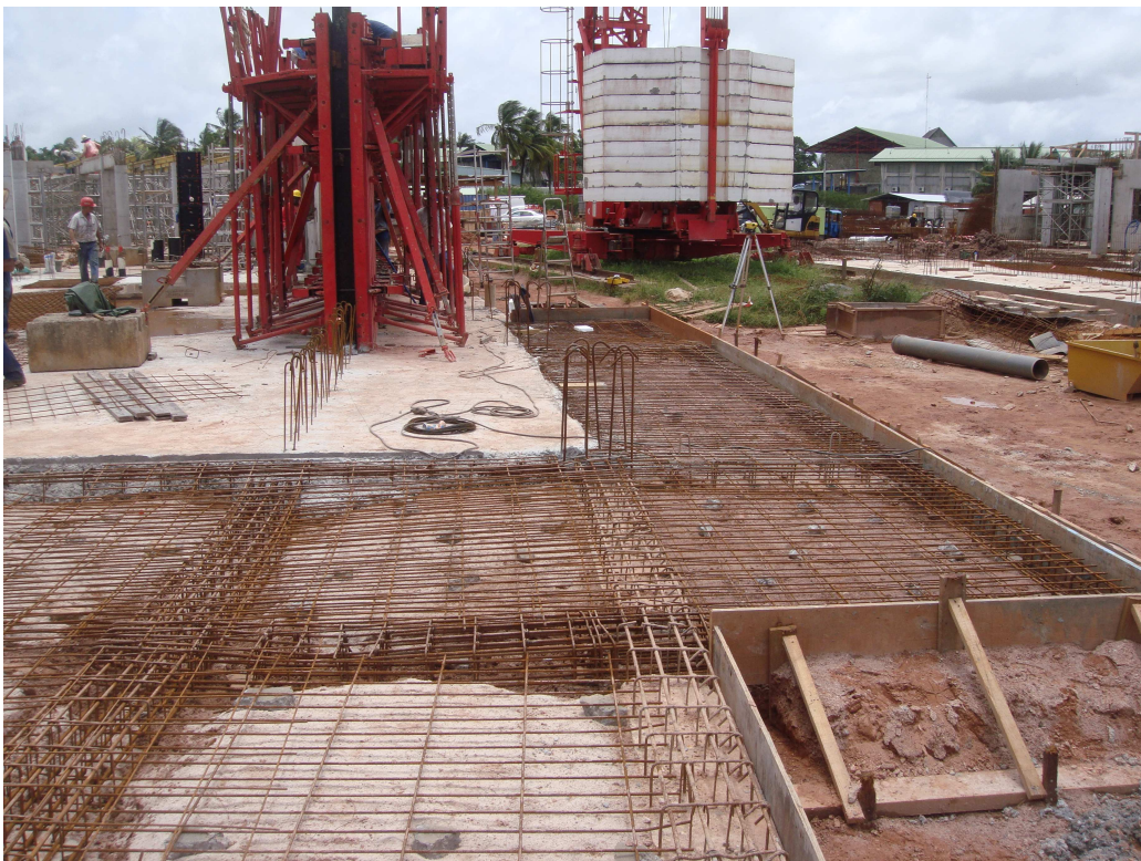
Photo 6 : ferrailage du dallage avant coulage du béton
