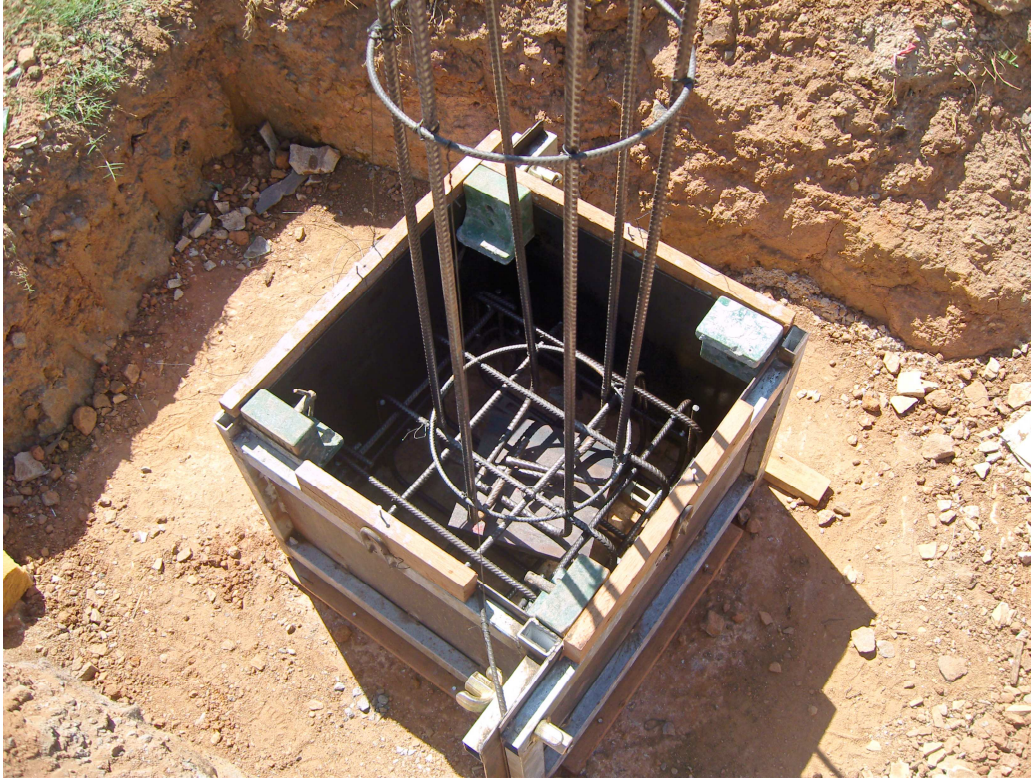
Photo 3 : massif en tête de micropieu
