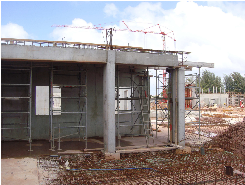
Photo 10 : poutres droites en tête de poteaux
