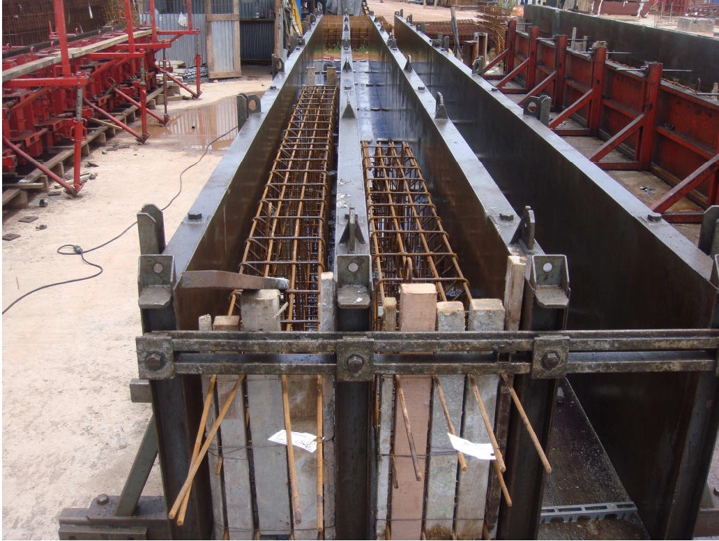
Photo 7 : préfabrication des poutres droites
