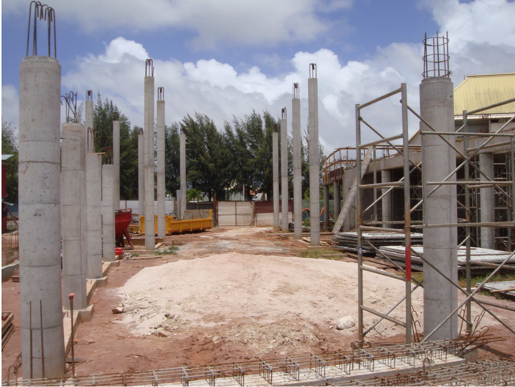
Photo 9 : poteaux simple et double hauteur du parking couvert
