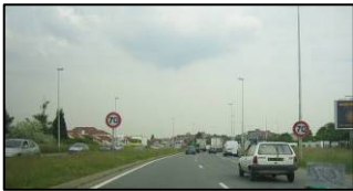
Le traitement routier de la RN 184
