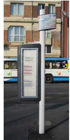
Photo 4 : Type de poteau choisi pour le TAD
