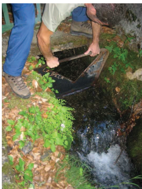
Figure 28 : A gauche, mise en place d'un déversoir amovible dans le canal de chasse de la prise de Géla (GU Nestes);
