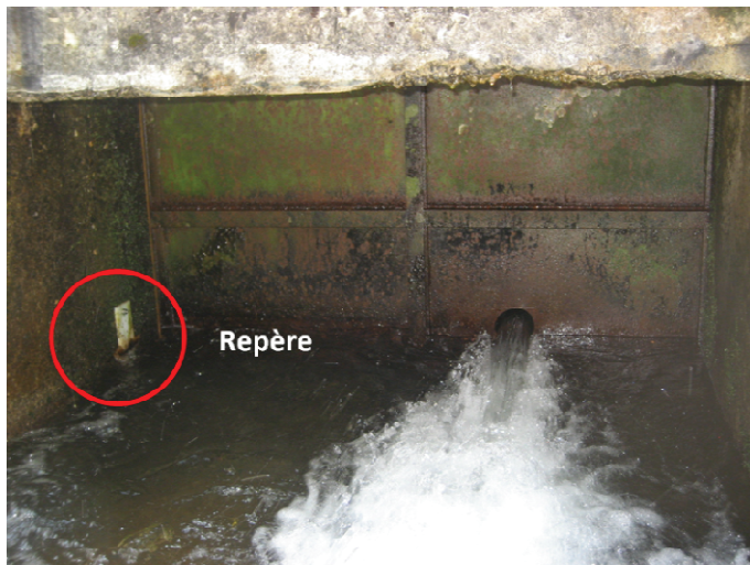
Figure 26 : L'ancien repère placé en aval de l'orifice a été complété par une échelle en amont pour connaître la valeur du débit (Prise du Nagear Supérieur, GU Vallées d'Ax)
