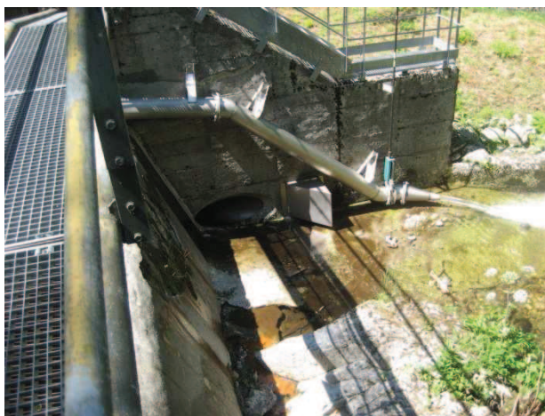
Figure 19 : Piquage complété par un ajutage amovible sur la prise d'eau de l'Aiguette (GU Aude-Tech)
