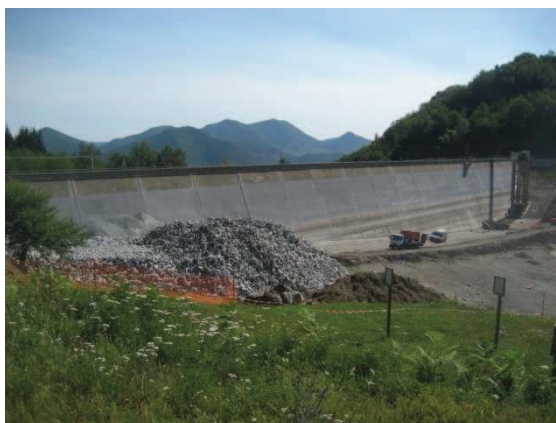
Figure 3: Exemple d'un chantier CIH, la vidange du barrage de Grandes Pâtures
