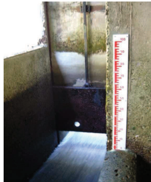
Figure 26 : L'ancien repère placé en aval de l'orifice a été complété par une échelle en amont pour connaître la valeur du débit (Prise du Nagear Supérieur, GU Vallées d'Ax)
