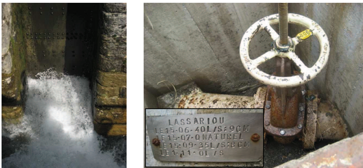
Figure 16: A gauche, restitution par ouverture de vanne à la prise de Lescun Inférieur (GU Baralet);
