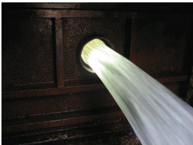
Figure 17 : A gauche, orifice percé dans une vanne de la prise de Balamet (GU du Couserans);
