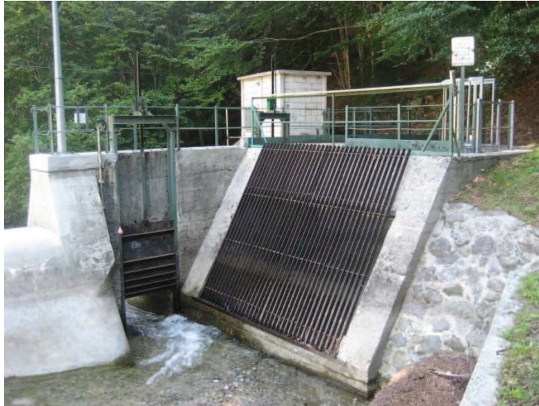
Figure 8 : L'ouverture de la vanne de vidange de la prise d'eau du Linas (GU Aude-Tech) permet d'évacuer les sédiments accumulés
