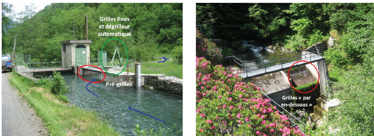
Figure 6 : A gauche, grilles et dégrilleur de la prise latérale d'Orle (GU de Couserans); A droite, grilles de la prise d'eau "par en-dessous" du Nagear Supérieur (GU Vallées d'Ax)
