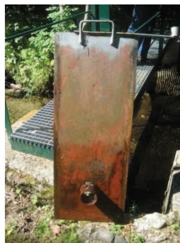
Figure 17 : A gauche, orifice percé dans une vanne de la prise de Balamet (GU du Couserans);
