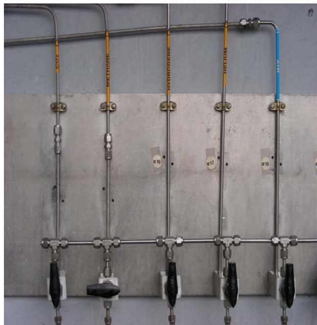
Figures 2.11 et 2.12 : Panoplie de détente du local de stockage après modification.
