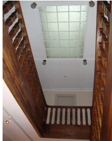
Fig. 38 - La nouvelle verrière vue du centre du hall.
