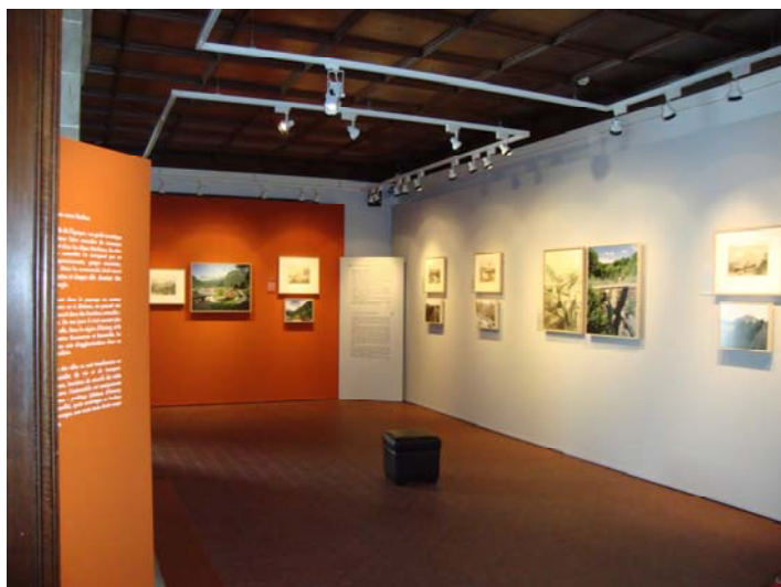
Fig. 36 - Accrochage des spots sur une structure métallique suspendue par des câbles.
