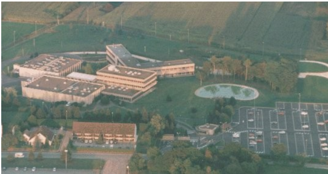
Figure 1 : Vue aérienne du site de Bessoncourt
