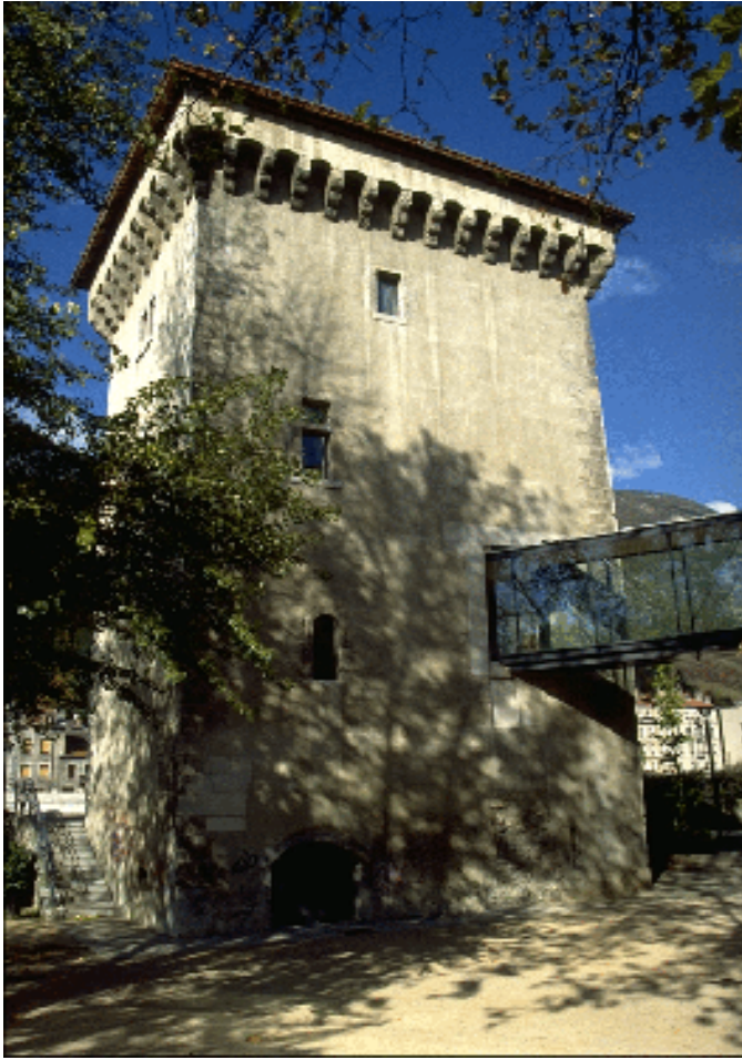
5. Photographie de la tour de L'Isle : le cabinet d'art graphique
