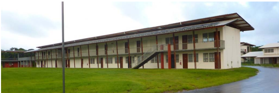
Figure 15 - Photographie du bâtiment H
