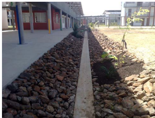
Figure 3 - photographie de la noue et de la coursive centrale
