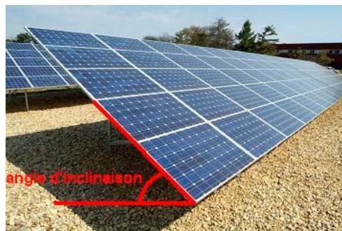
Figure VI-5 : Angle d'inclinaison d'un capteur solaire
