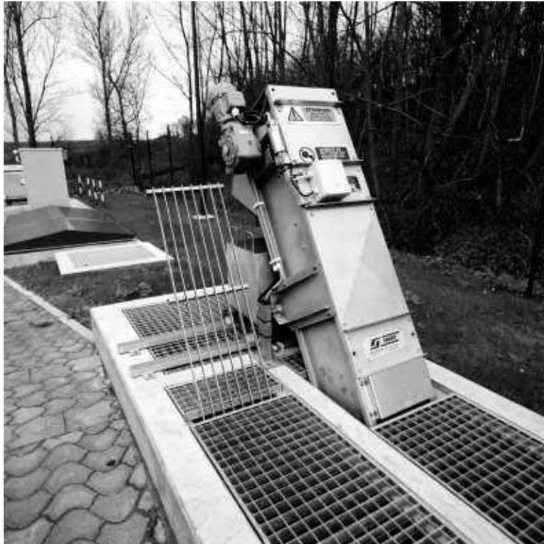
*Figure N°23 : Dégrilleur automatique avec by-pass manuel.*
