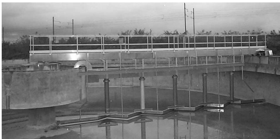
*Figure N°44 : Clarificateur à pont suceur*
