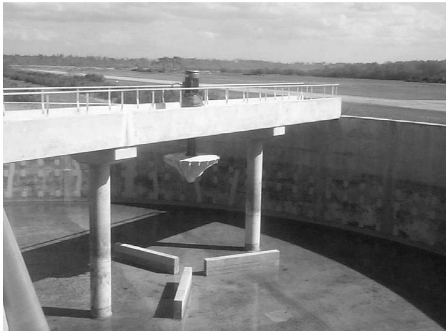
*Figure N°38 : Bassin aéré mécaniquement par des turbines de surfaces*
