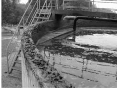
*Figure N°51 : Dégradation du béton d'un voile de bassin d'aération*
