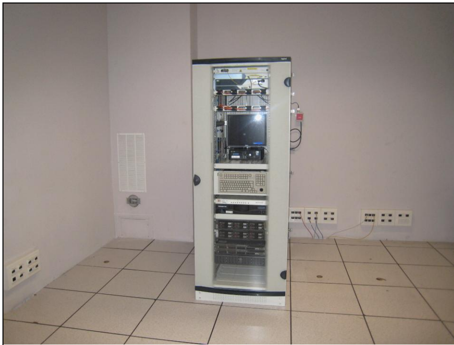
FIGURE 30 : ARMOIRE RESTANTE SUR LE SITE DE MALAUNAY
