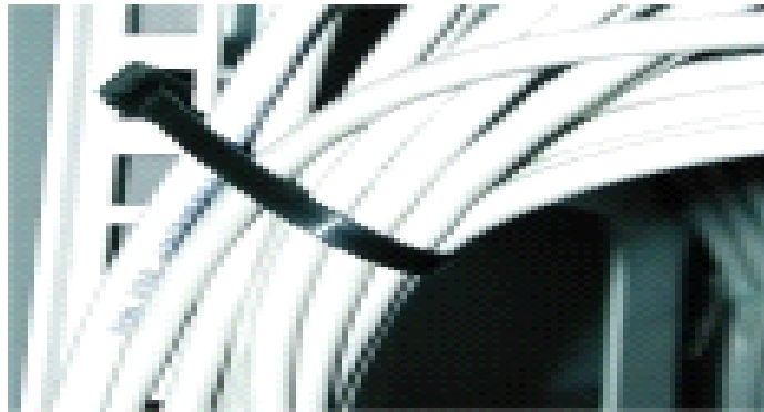
Figure 1 : Photo d'un collier de serrage pour la fixation d'un faisceau de câbles [24]
