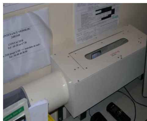
Figure 57 : Départ du pneumatique de la PUI
