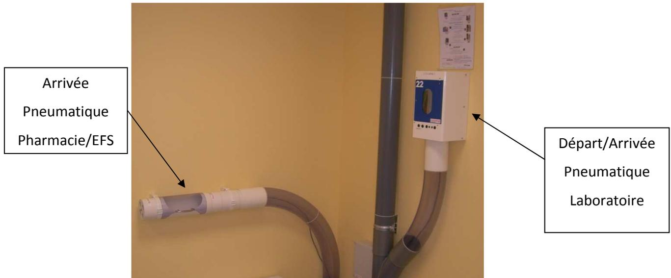
**Figure 58 : Arrivée des réseaux pneumatiques dans les unités de soins**
