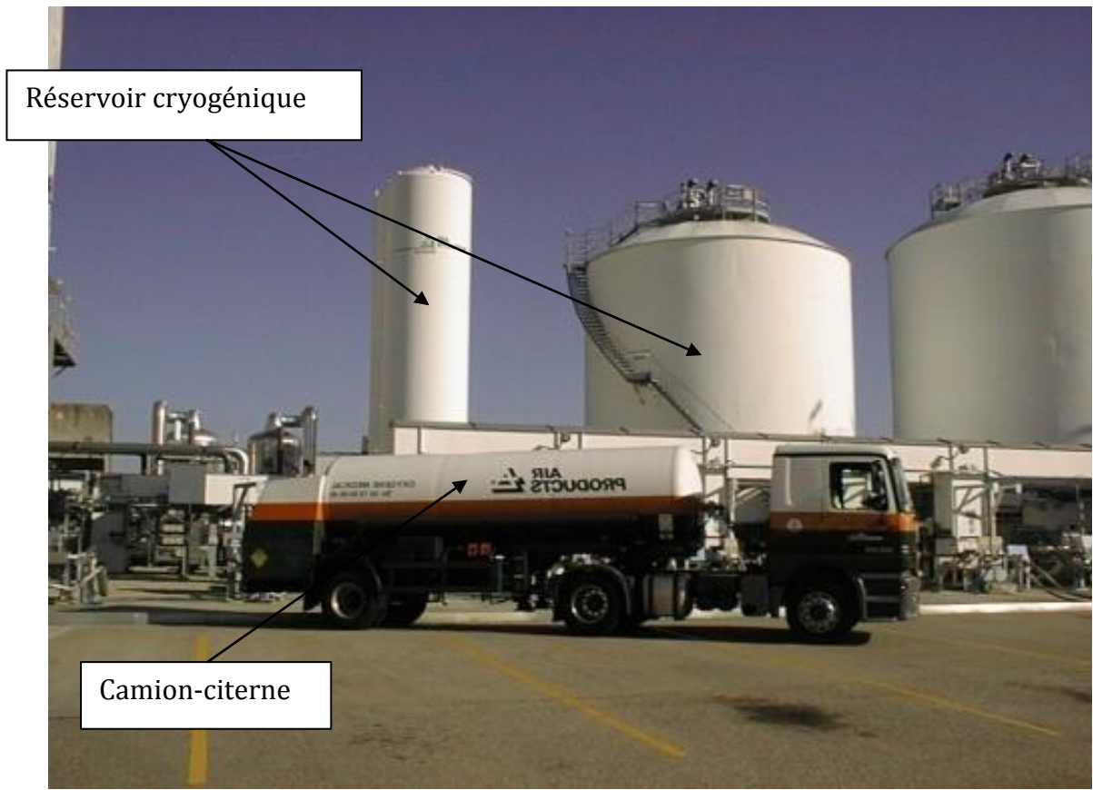
Figure 8: Réservoirs cryogéniques et camion citerne
