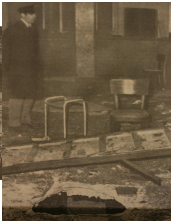
Le hall de la Banca dell'agricoltura (à gauche) et le cratère provoqué par l'explosion, in La Stampa , 13 décembre pp.1 et 2.
