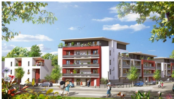
Figure 38 – Immeuble collectif à Villetaneuse, France. Architecte : Cabinet François Pellegrin / Maitrise d'ouvrage : Sodearif Source : http://promoteurs.arka-studio.fr/illustration-immeublecollectif/1544-illustration-villetaneuse.html
