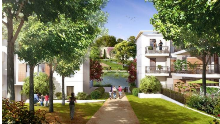
Figure 31 - Immeuble collectif Les Nymphéas en France. Architecte : M. Jacques Ressay. Source : http://promoteurs.arka-studio.fr/illustrationimmeublecollectif/1565-illustration-les-nymphéas.html
