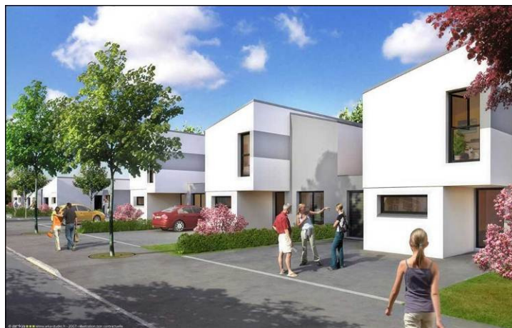
Figure 26 - Projet de logement Le Clos des Feuillantines à St Berthevin, France. Architecte : Archipole Source : http://promoteurs.arkastudio.fr/illustrationmaisonindividuelle/1071-illustration-le-clos-des-feuillantines-a-st-berthevin.html
