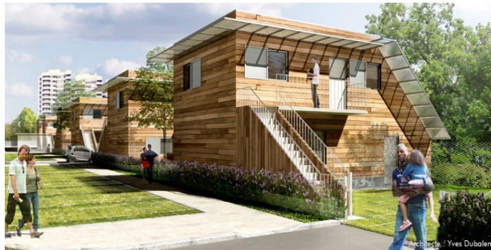
Figure 19 - Éco quartier en France. Architecte : Yves Dubalen. Source : http://www.domyhabitat.com/gammes_34_les-eco-quartiers_.html
