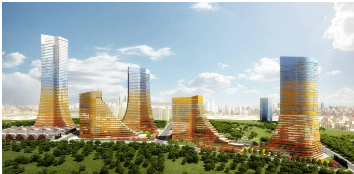
Figure 50 : Le projet Varyap Meridian , certifié LEED
