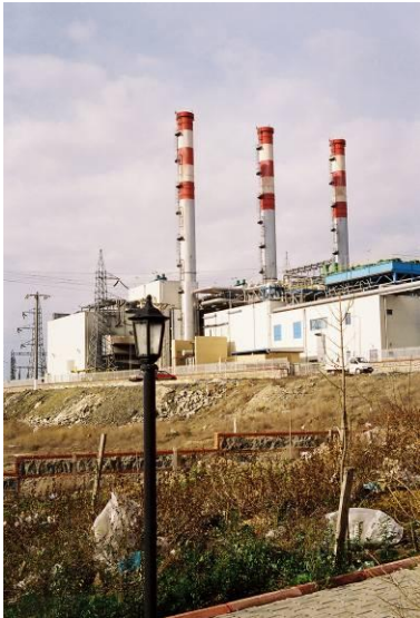
Figure 41 : Centrale thermique alimentant le réseau de chaleur d'Esenkent
