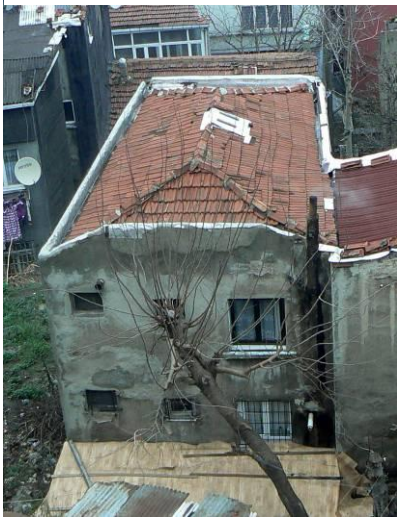
Figure 34 : Logement raccordé au réseau de gaz naturel et disposant d'un poêle
