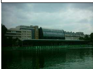
Photo.5 : chantier du cinéma MK2 Quai de la Loire
