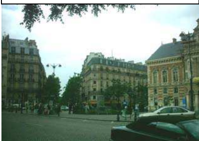
Photo. 5. Immeubles haussmanniens, près de la mairie du 19e
