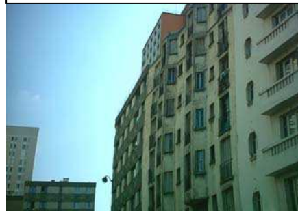
Photo. 6. Immeubles anciens dégradés, rue de Crimée
