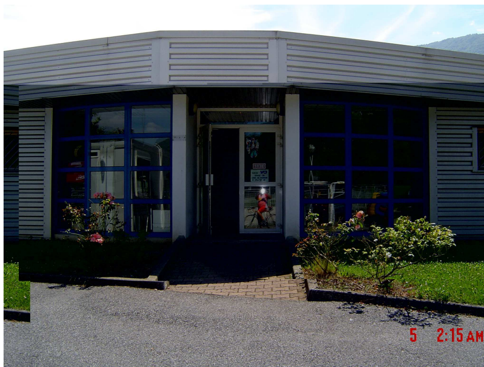
Figure 4 : L'entrée du Centre VFD de Vizille
